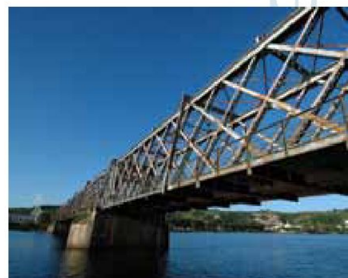
Ponte Dom Pedro II sobre o rio Paraguaçu, ligação entre os municípios Cachoeira e São Félix
