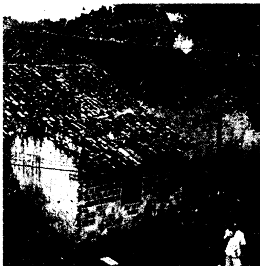
Lateral do terreiro Bogum antes da recuperação do telhado (22/7/87)
